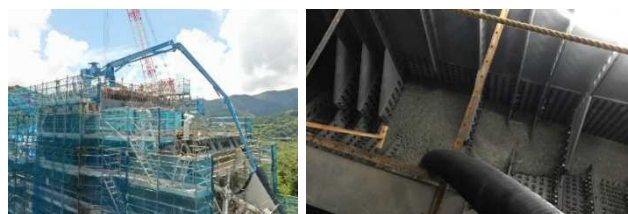
写真-2 全体概況(左)と鋼殻内の充填状況(右)
