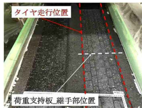
図7 水張試験後の舗装路面
