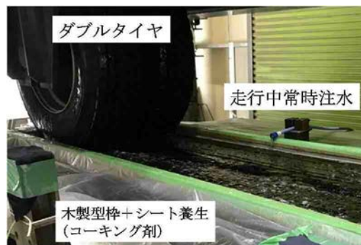
図6 水張試験状況
