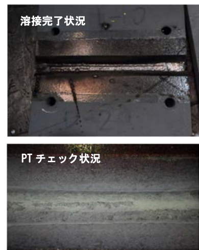
図-3 溶接施工状況および欠陥チェック
