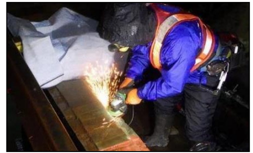
写真② カバープレート撤去作業
