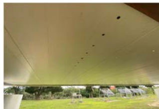
図3 デッキ下面計測孔
