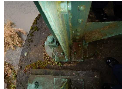
写真-2 鋼製支承の状態
