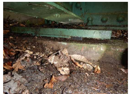
写真-1 ゴム支承の状態
