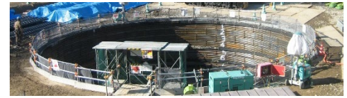
写真-1 深礎工法用ライナープレート立坑
