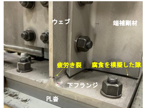
図 1 I ビーム橋の疲労き裂再現事例
