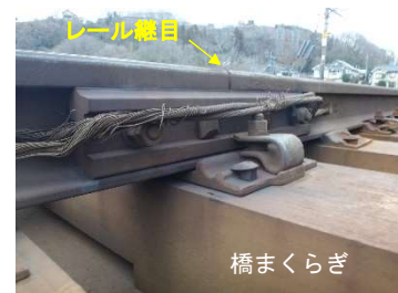
図1 レール継目
