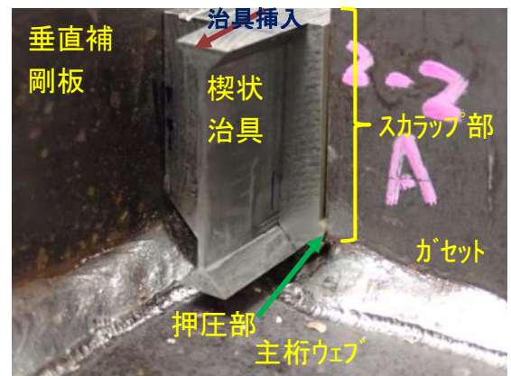
図3 スクラップ部押圧処理要領と治具形状概要
