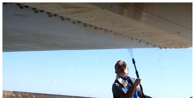
写真-2 水洗いによる塩分除去の様子
