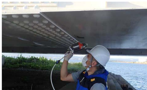
写真-3 シリコンの吹き付け塗布の様子
