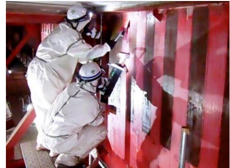
図-1 IH 塗膜剥離施工の例
