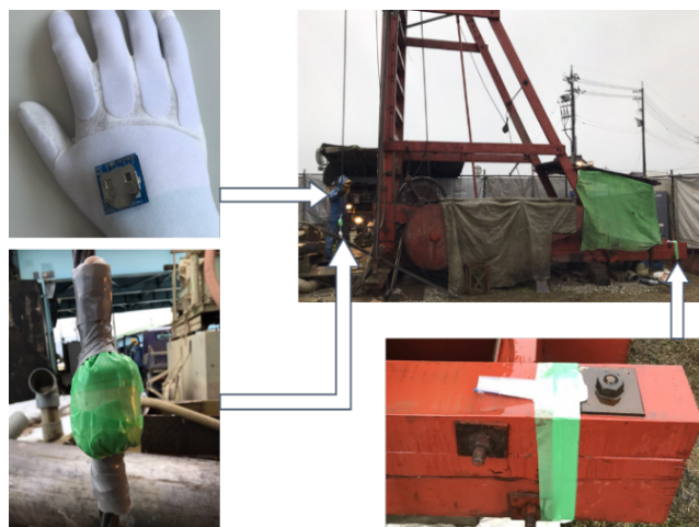
写真-1. 加速度センサー設置状況
