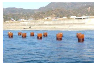
写真-1 鋼管杭の状況
