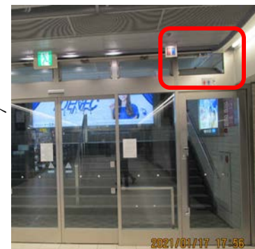
写真1 扉上部開放による換気
