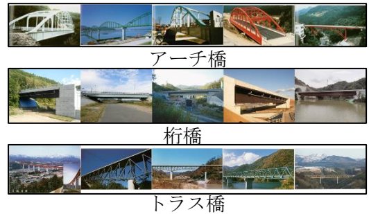
図4 橋梁形式別写真の一例
