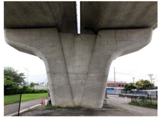
写真-1 調査対象橋脚
