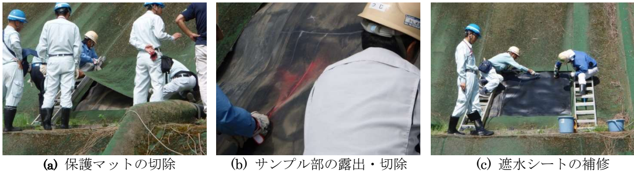
図4 遮水シートのサンプル採取状況例
