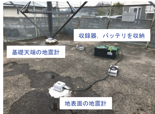
写真-1 地震観測装置の設置状況
