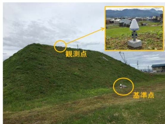
図5 盛土における連続稼働試験の状況
