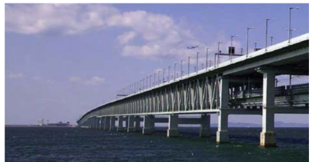
写真-1 関西国際空港連絡橋
