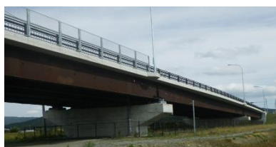
図-1 道路橋外観
