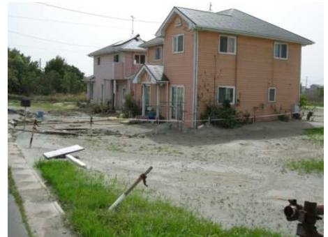
写真-1 宅地の被災状況
