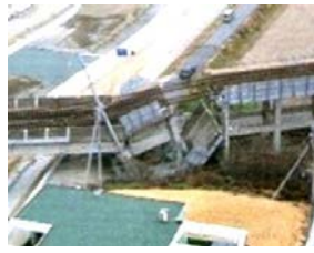
(a) 伊川橋東橋台(神戸市)
