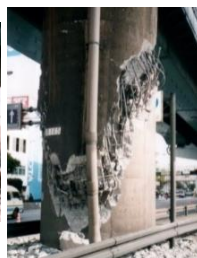
破壊面に空間がある破壊状況(南西面) 図5 西 P165 近影
