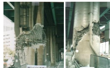
(a) P402 (b) P414 隣の柱はほぼ無傷(拡大すれば判明) 図3 橋脚の孤立的破壊例(2)
