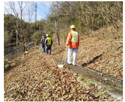
図1 のり面小段の牽引式電気探査状況
