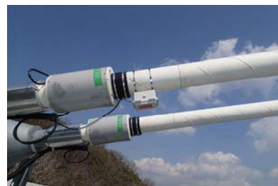
写真-2 斜ケーブル振動計測
