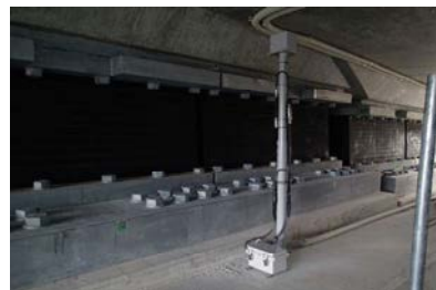
写真-1 支承変位計測
