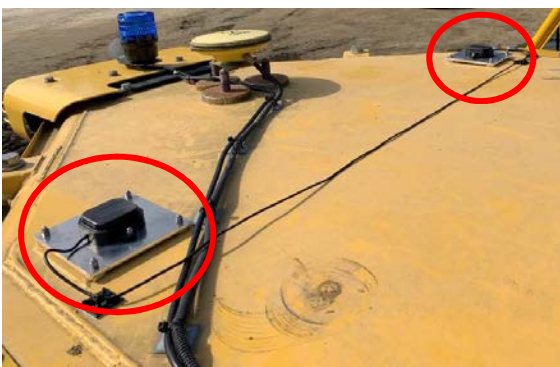
図-3 GNSS アンテナ重機設置状況
