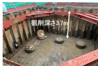
写真-1 掘削後の状況
