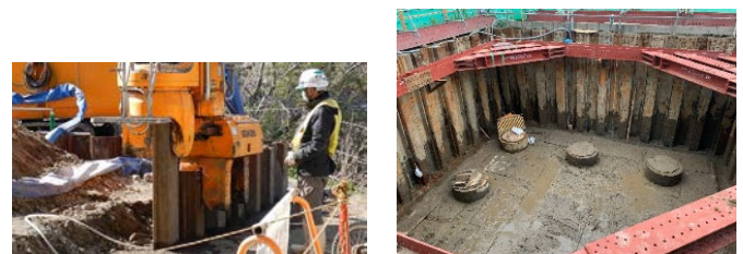
写真-4 鋼矢板の建込み状況 写真-5 掘削後の状況
