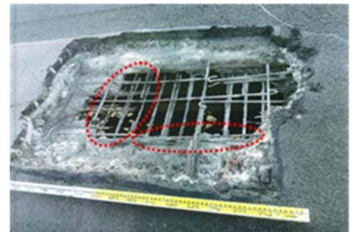
写真-1 床版の土砂化による連結用 PC ケーブルの破断
