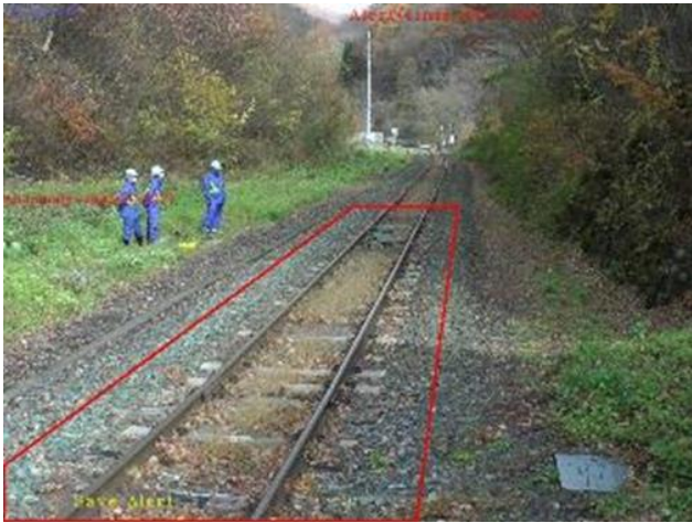
写真-3 入力画像例 (赤枠：検知エリア)
