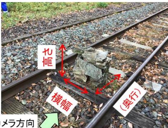
写真-4 石の設置状況 (表-1の撮影No3の例)
