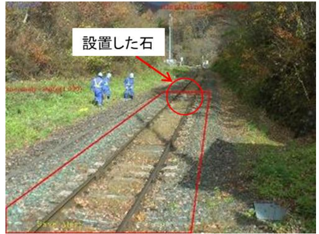
写真-5 石の設置状況
