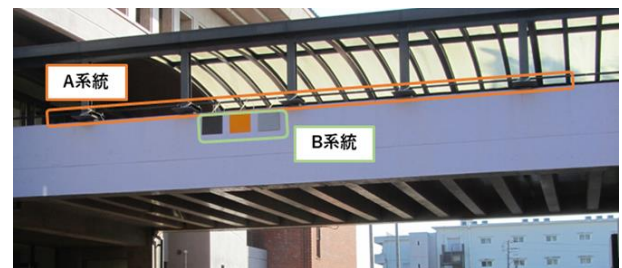
図-1 ターゲット設置状況
