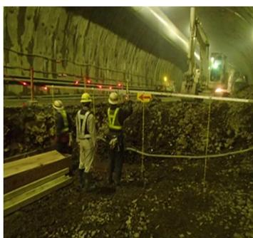
写真-1 従来のインバート掘削状況
