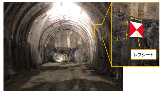
図-3 測量マーカー設置状況
