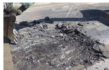
写真-1 路面上での車両火災後の舗装の撤去状況
