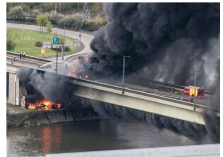
写真-1 橋梁火災事例 1)
