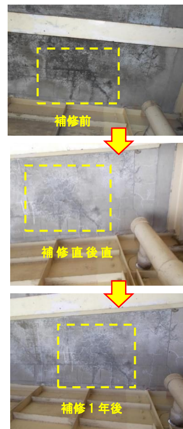
写真-2 床版下面状況
