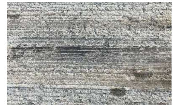
写真-4 切削+剥離除去
