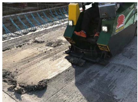
写真-3 スクレーパーによる防水材除去
