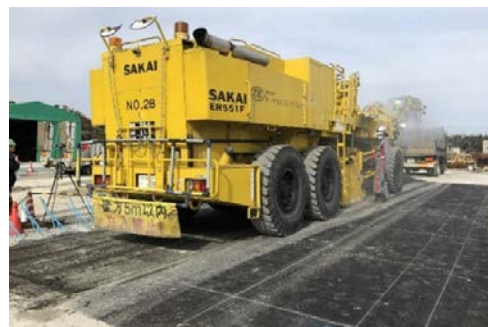
写真-1 切削機による切削試験
