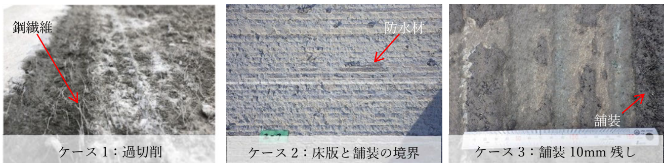
写真-2 切削後のUFC床版
