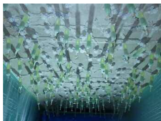
写真-2 注入状況
