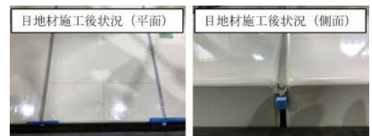
写真-3 目地施工後状況
