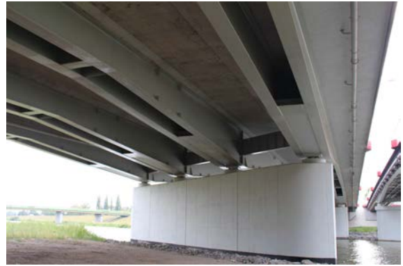
写真-1 新形式の二重合成桁橋
