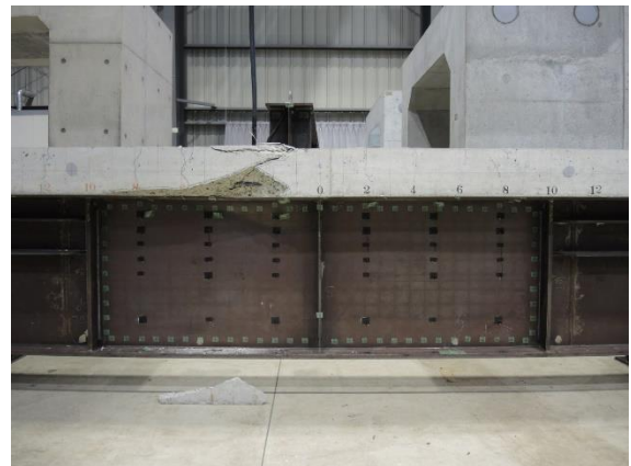
図-4 実験終了後のテストパネルの写真
