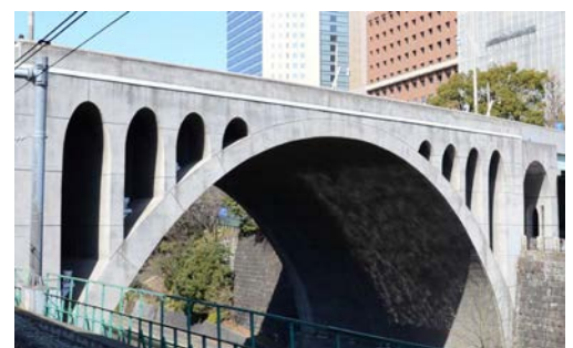
写真3. 平成の聖橋（石張り風仕上げ）
