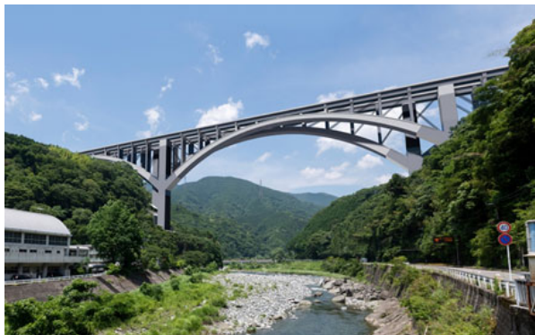
図-1 河内川橋（仮称）
