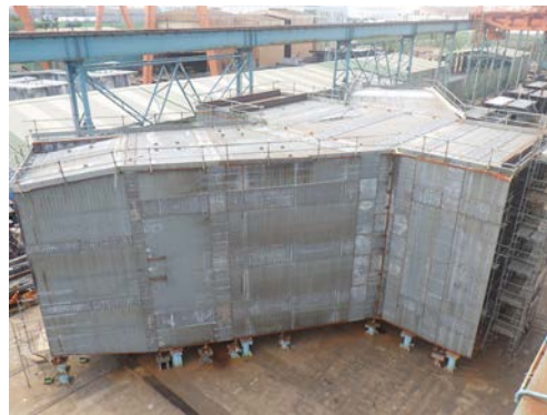
写真-1 スプリングング鋼殻部（仮組立時点）
