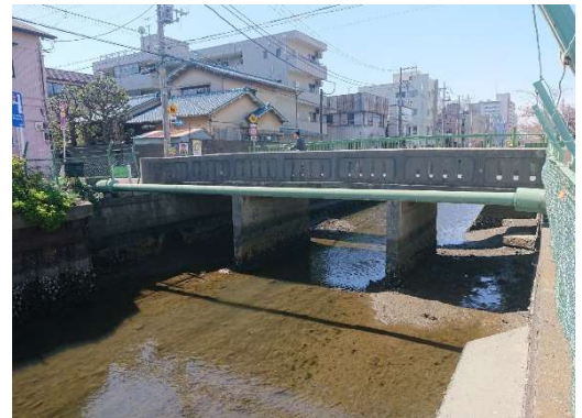
写真-1 検討対象橋梁
