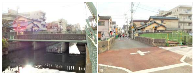
写真-1 現在の対象橋梁
