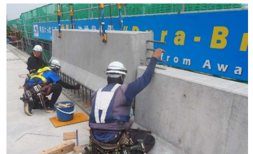
写真-1 壁高欄の架設
