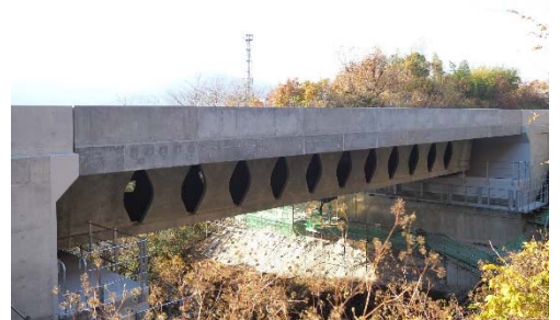
写真-2 別壱谷橋
