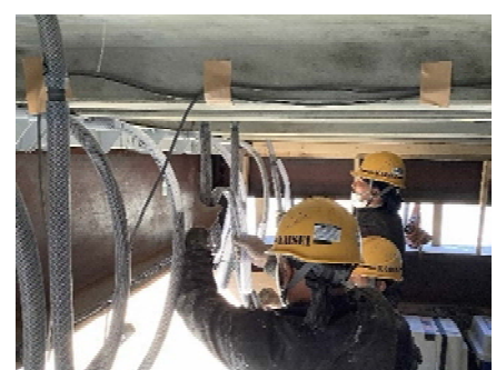
③水平目地およびスタッド箱抜き部 無収縮モルタル充填状況
