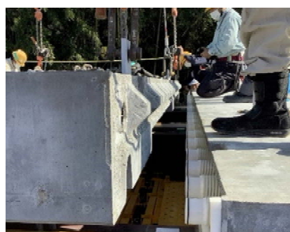
②床版パネル架設状況（スライド前）
