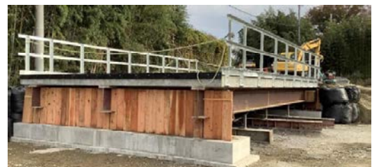
実証橋全景（スロープ埋め戻し）
