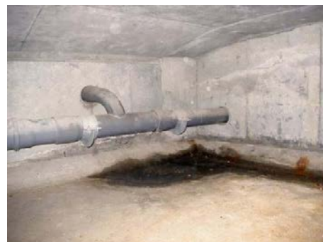
写真 1 PC 箱桁橋塩害の事例
